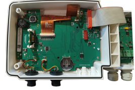
无线通讯模块安装成功
